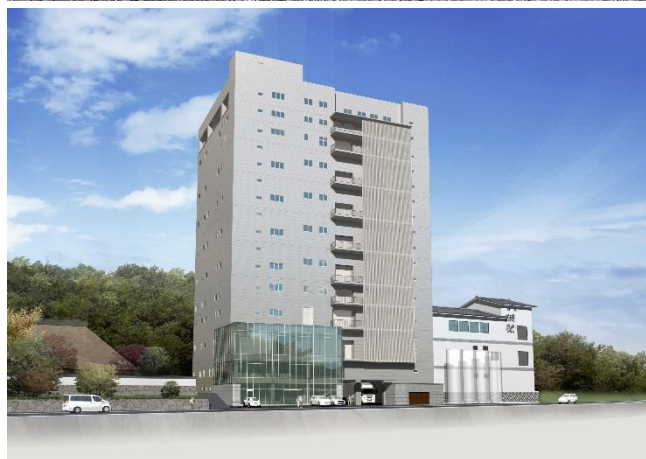
旭酒造の旧社屋(上)と現在建築中の本蔵(下)
